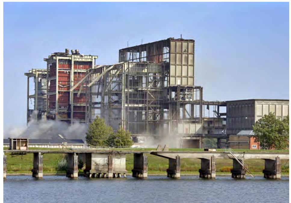
Ontmantelen van de IJsselcentrale
